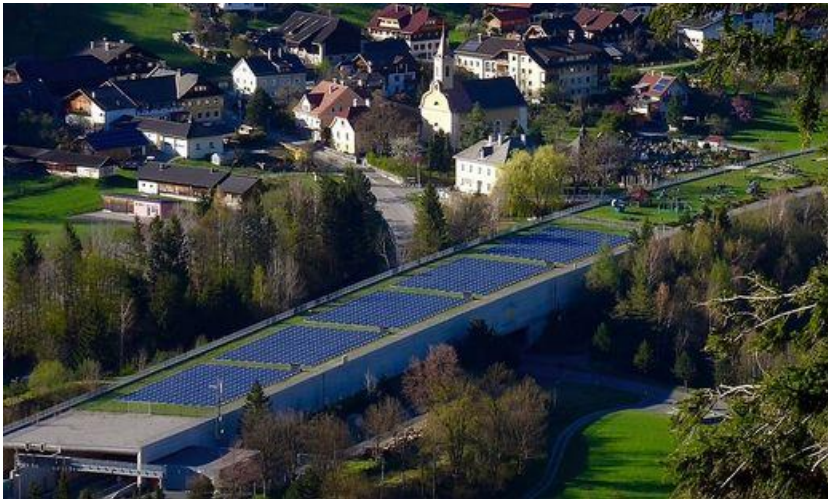
Die neue Photovoltaikanlage in Trebesing mit einer Gesamtfläche von 2000 Quadratmetern, dahinter ist der Kinderspielplatz © KK/WILLI PLESCHBERGER
