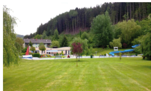
Das energieautarke Freibad in Gmünd – warmes Wasser nur mit der Energie der Sonne
